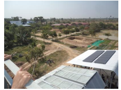
Avec la technique et les panneaux solaires de l'aide Schneider Electric.
